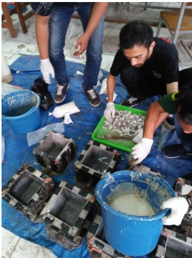
Dokumentasi pada tahap penyiapan campuran agregat kasar
