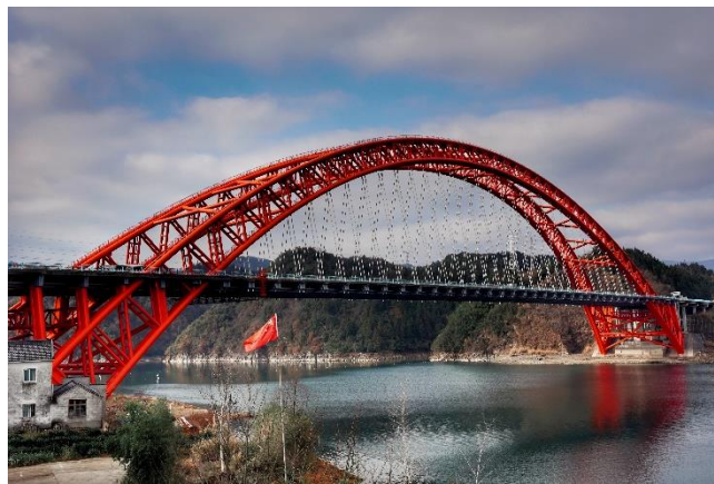
Gambar 2. 17 Jembatan tipe pelengkung ( Arch )
