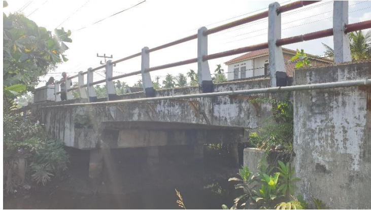
Gambar 2. 14 Jembatan tipe pelat
