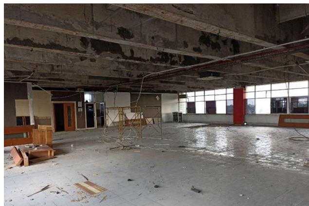
GAMBAR 6 PERSIAPAN & SURVEY LOKASI
