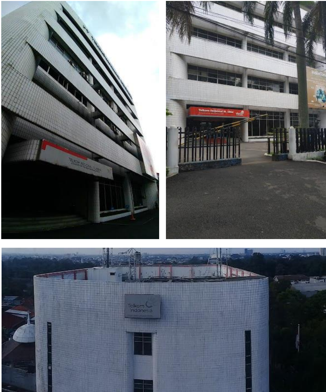
GAMBAR 2 GEDUNG SEBELUM DIRENOVASI
